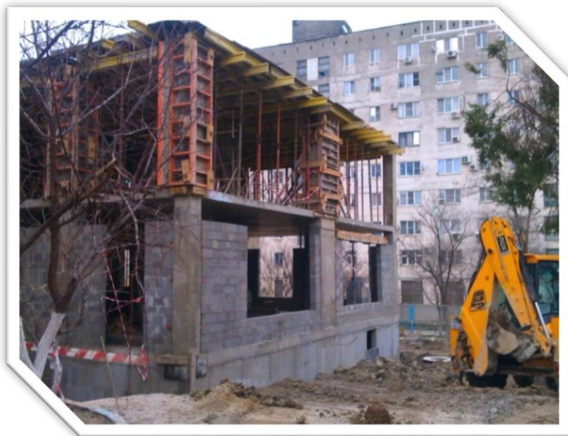
Строительство нового корпуса детского сада
