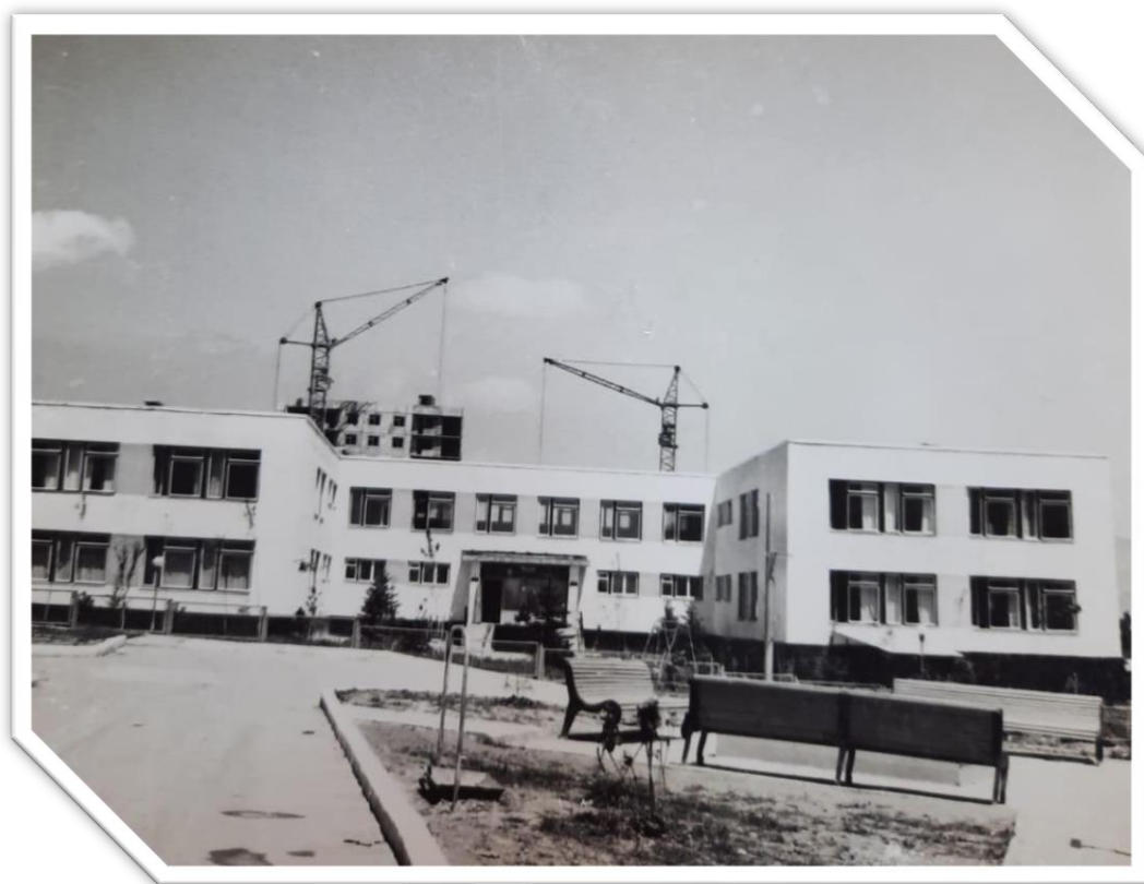
На фото: строительство детского сада №63 г. Новороссийск (1970г.)
